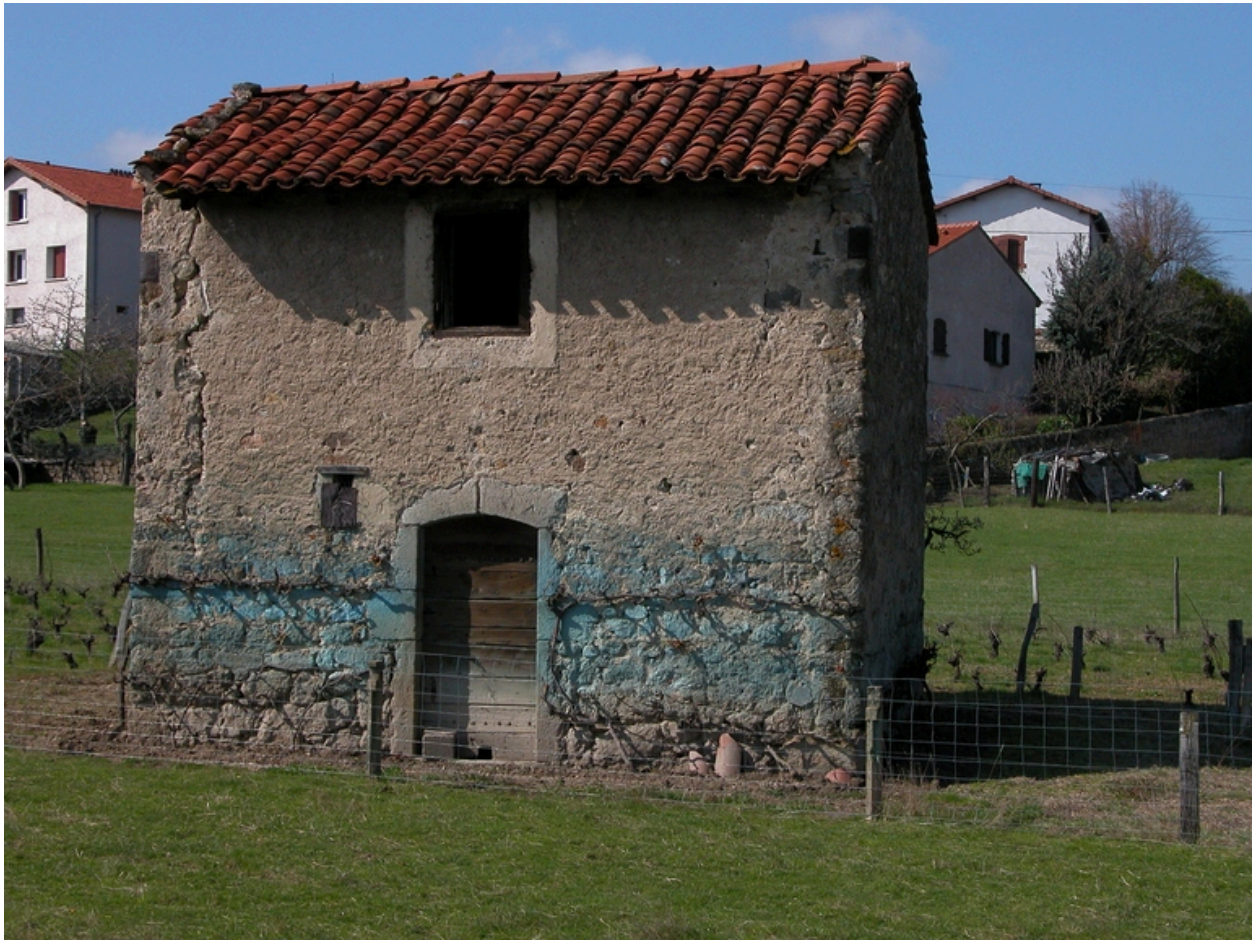
Vue d'ensemble de la façade principale.
