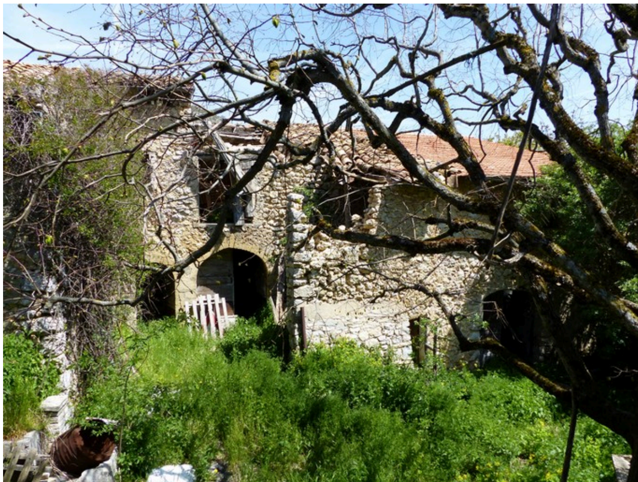
Ensemble oriental. Partie sud. Vue d'ensemble prise de l'ouest.
