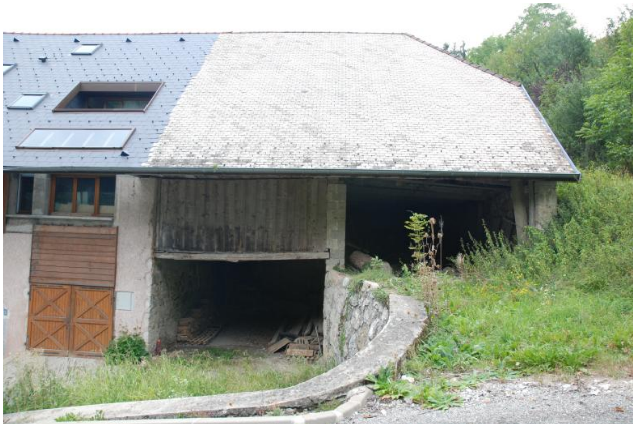
Détail de l'entrée de la remise située à l'est.
