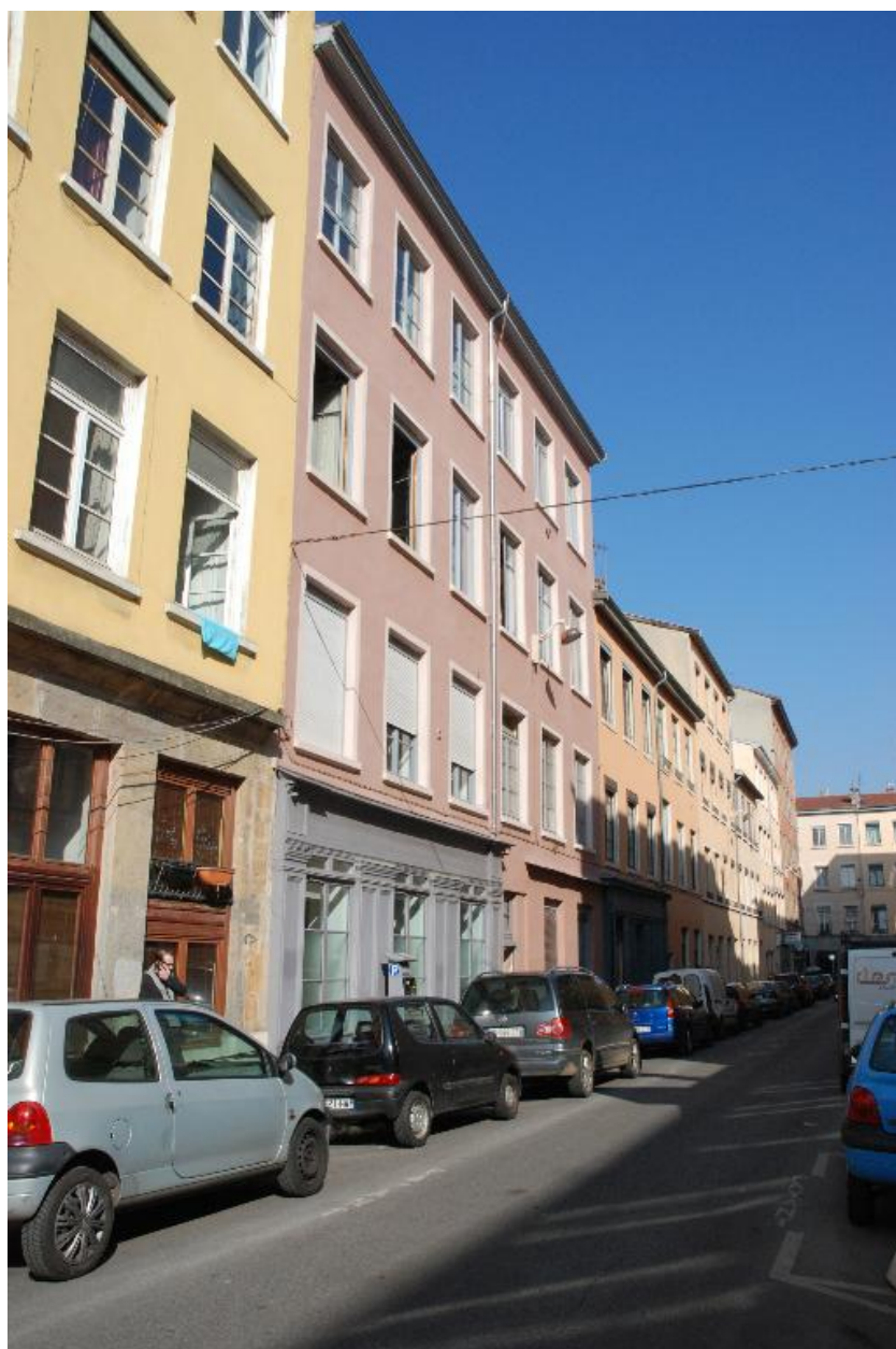
Vue d'ensemble sud est
