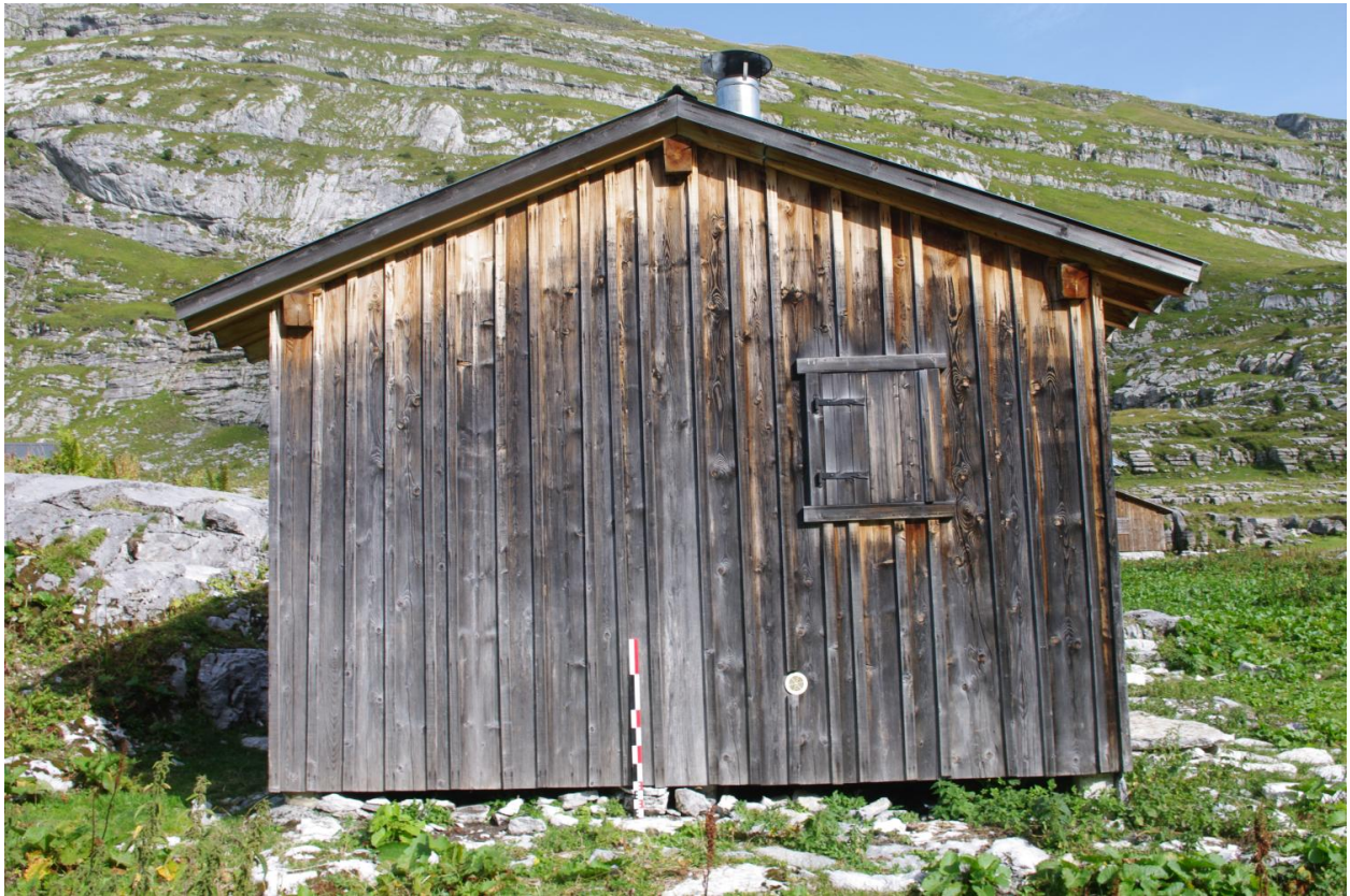
Vue du mur pignon ouest
