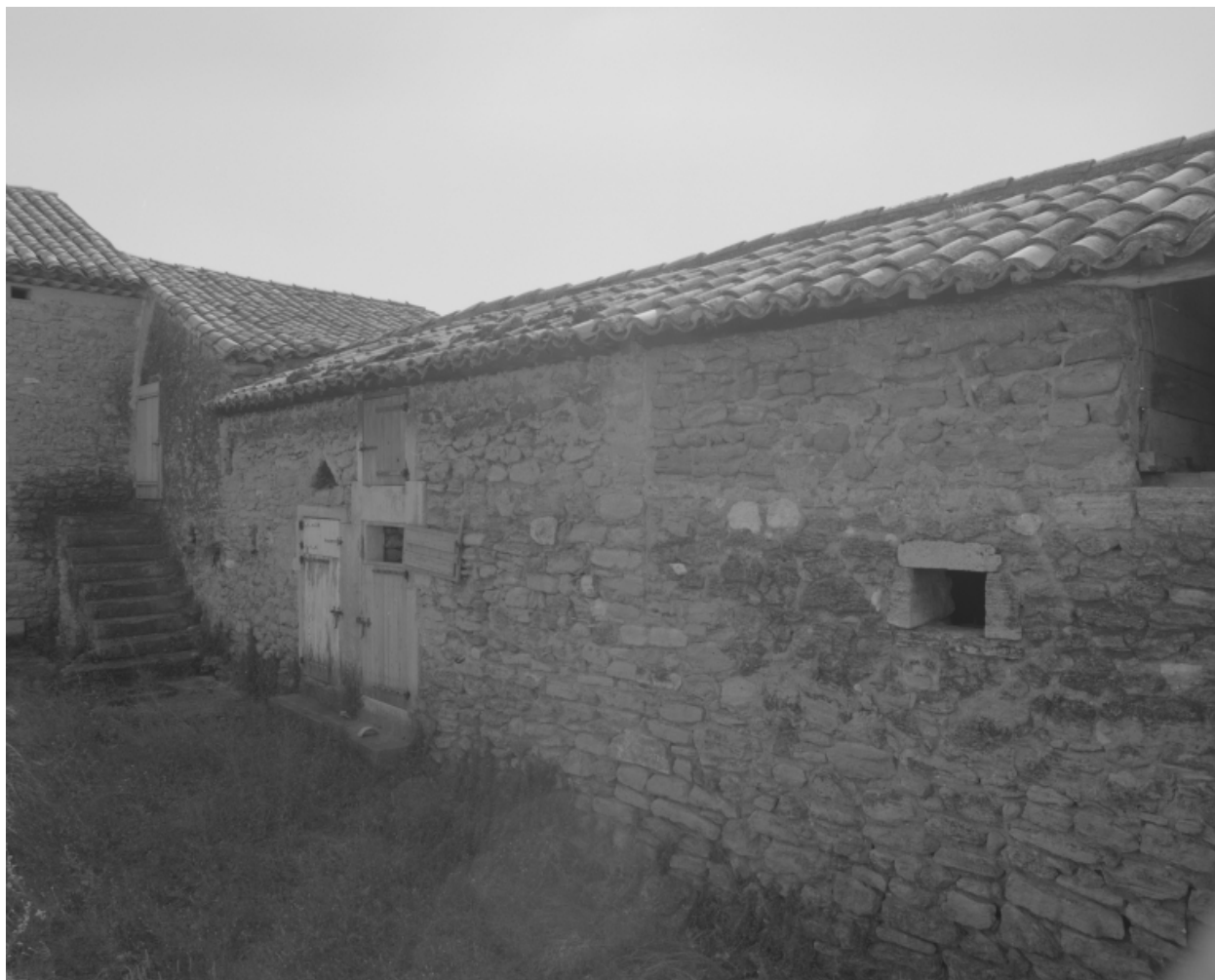
Graillon. Une partie des dépendances agricoles (étables, grenier et fenil).
