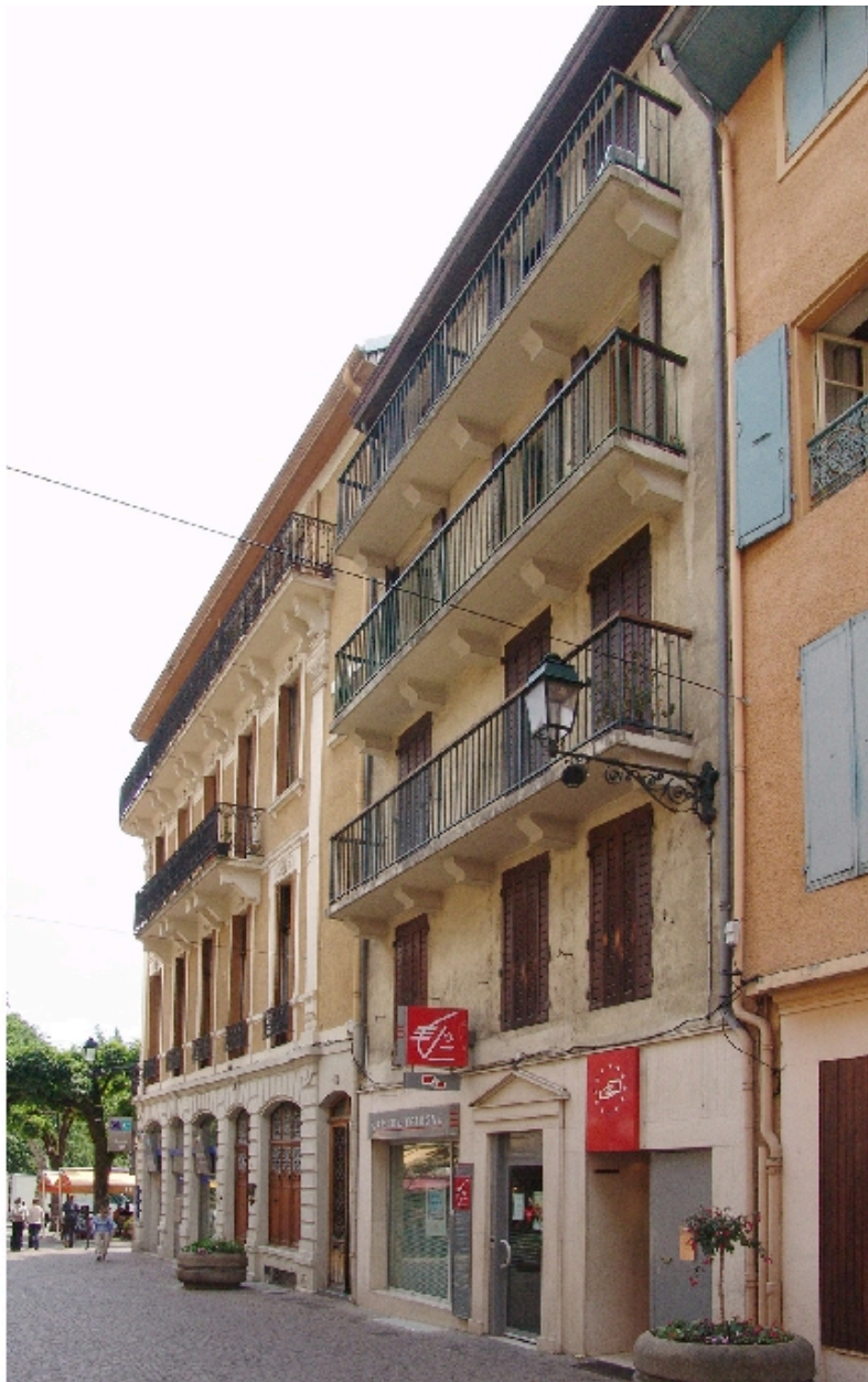
Façade vue de trois quart droit
