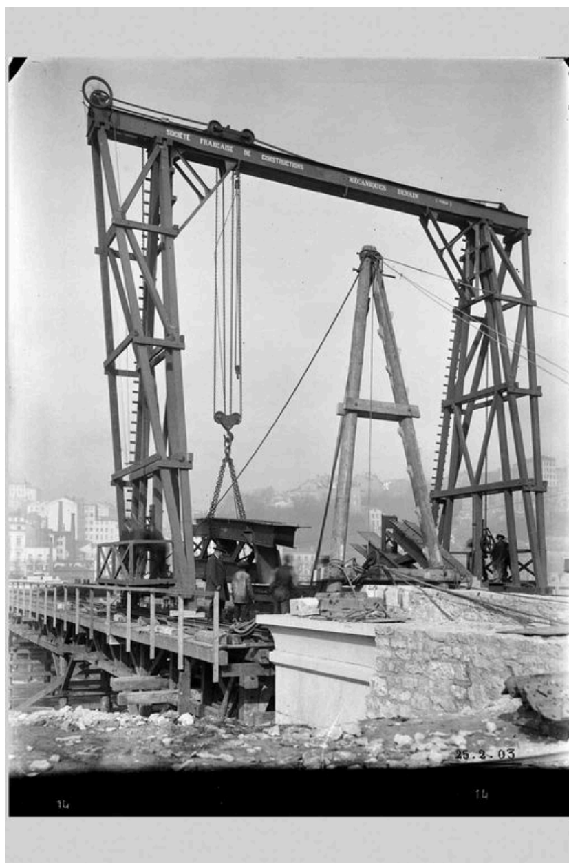
La construction du pont de la Boucle. La pose des poutrelles. Photogr., 25 février 1903 (Arch. mun. Lyon. 15 Ph 1810)
