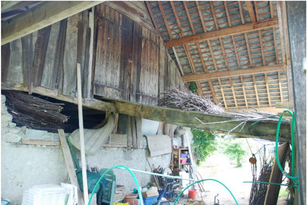
Détail de la mise en oeuvre du pont.
