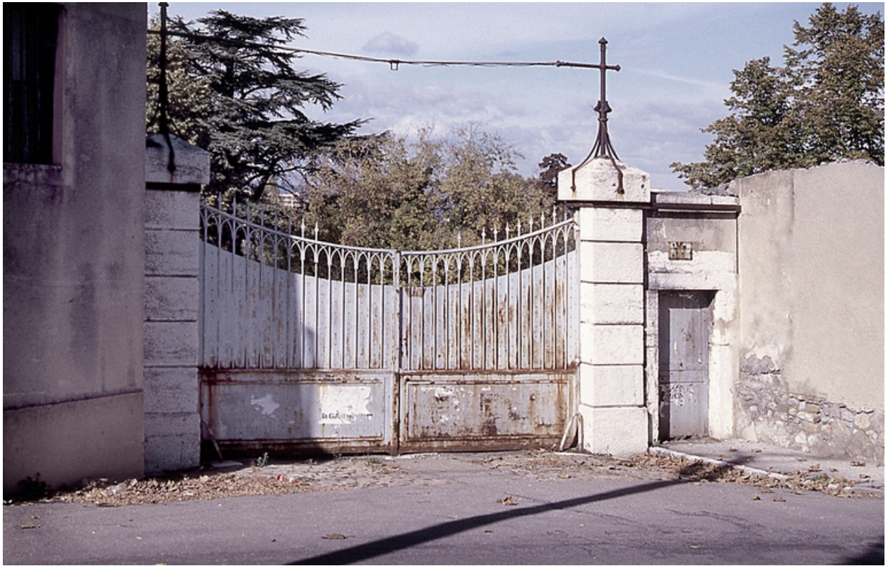
Vue sud-ouest portail d'entrée
