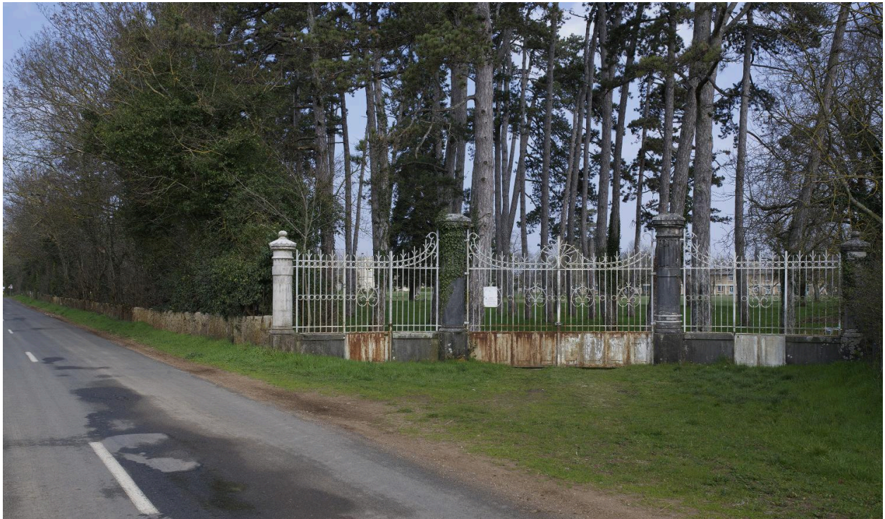
Vue du portail sud, bosquet de pins et clôture en dalles de pierre
