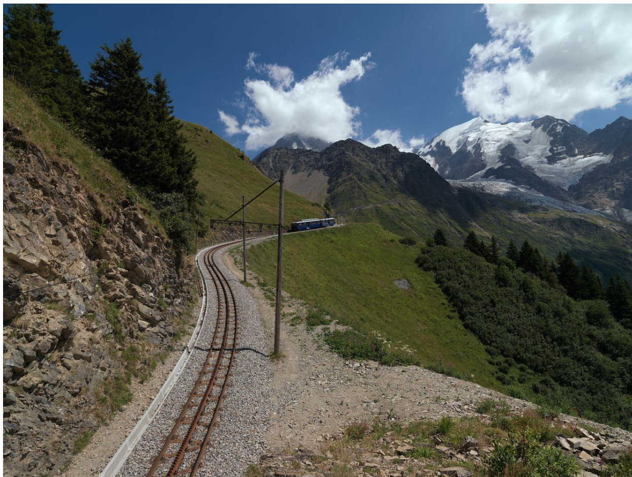
Voie ferrée du TMB
