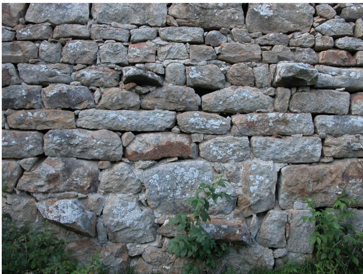
Détail des maçonneries.
