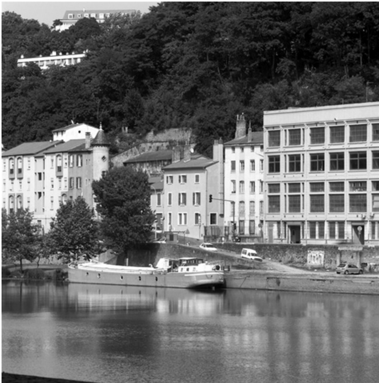
Vue ouest du site
