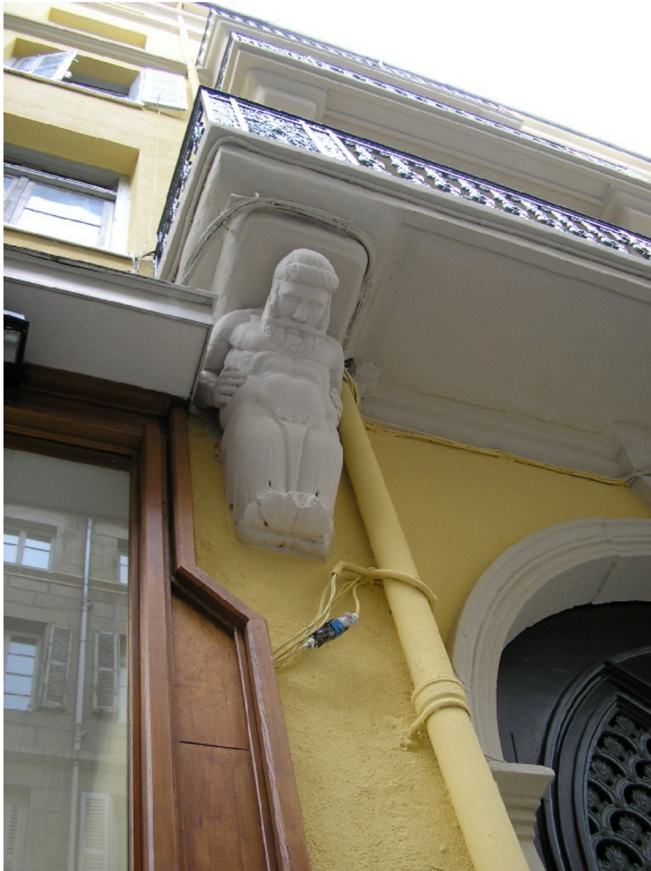
Détail d'un atlante supportant le balcon
