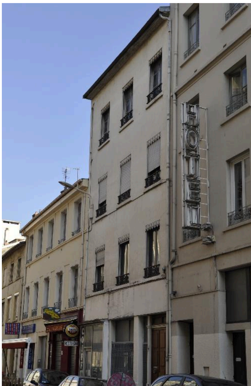
Vue générale de l'élévation sur rue
