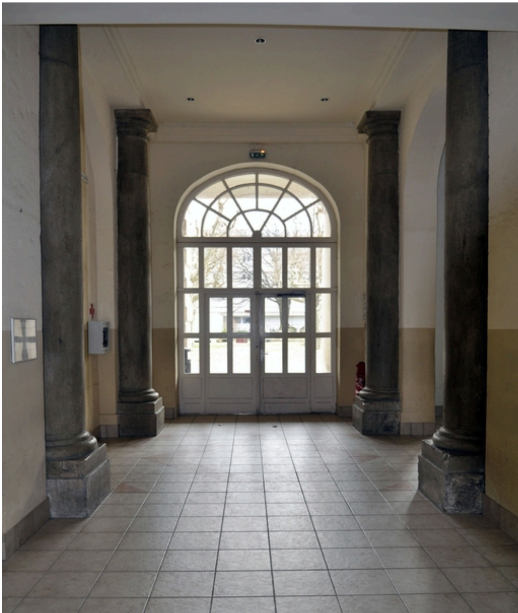
Bâtiment C. Vue intérieure de l'atrium, partie sud du bâtiment, ouverture sur le parc.
