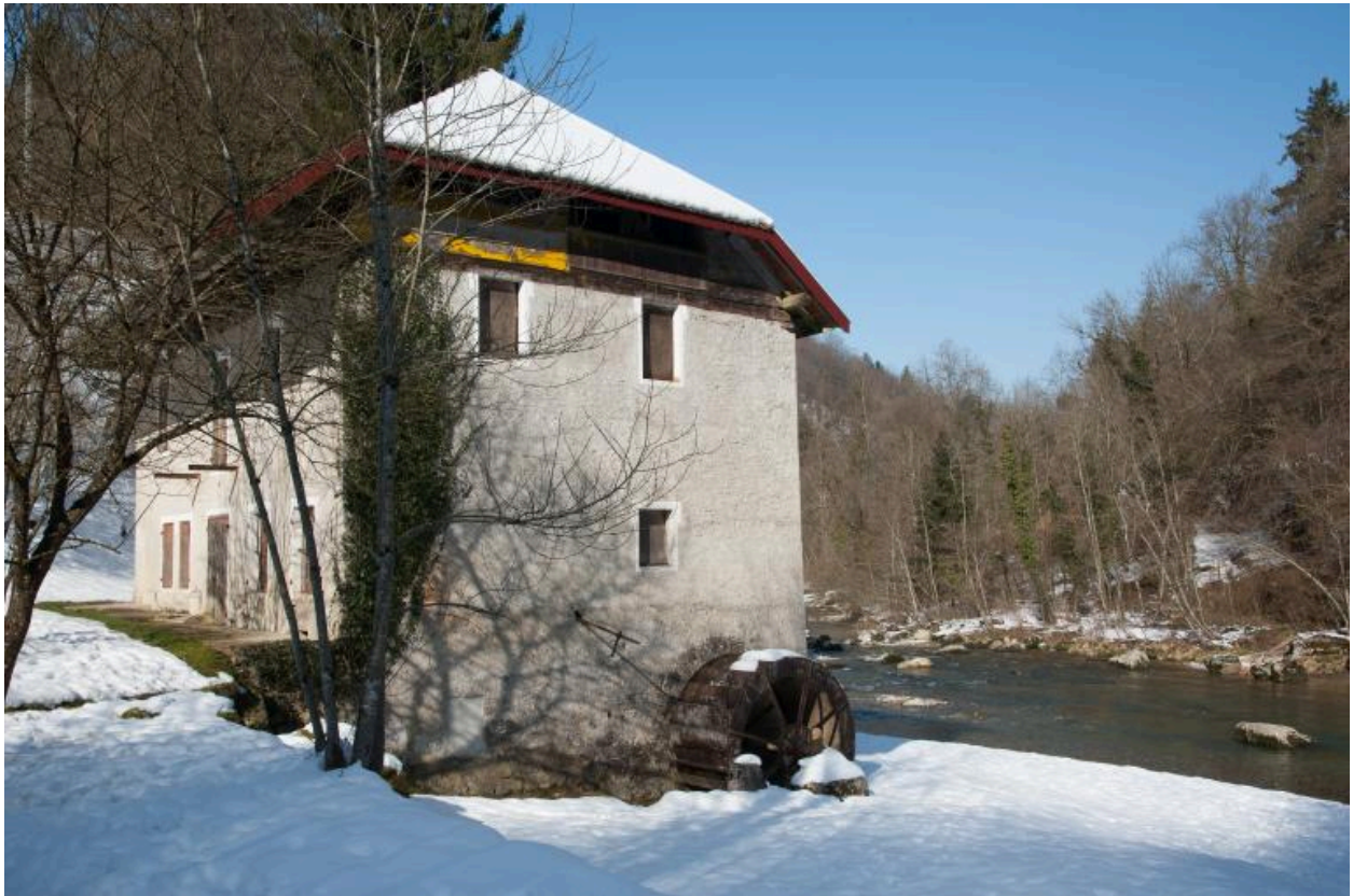
Vue d'ensemble du bâtiment principal.
