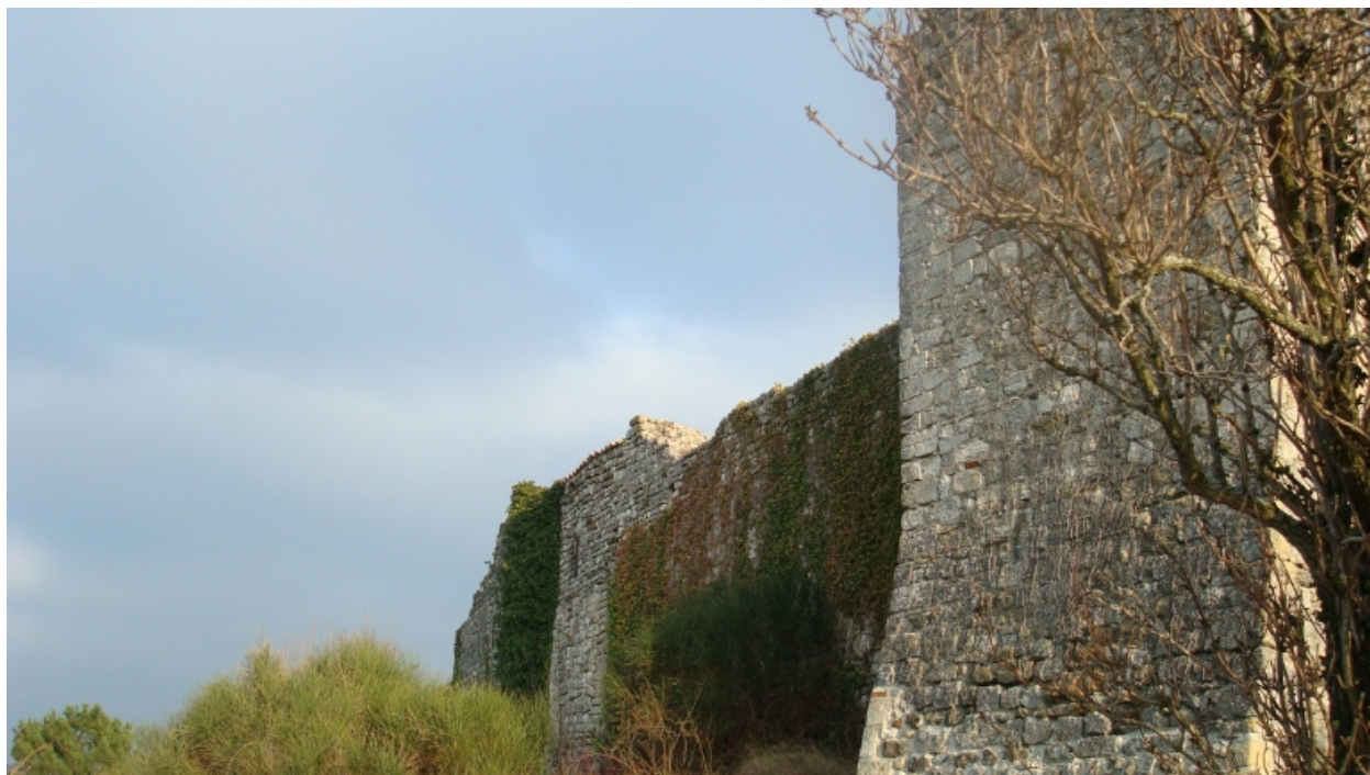
Fortification du Château, vue partielle depuis l'ouest : courtine et tour.
