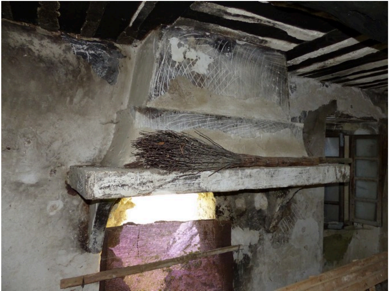
Second étage de soubassement, cuisine. Mur sud, cheminée.
