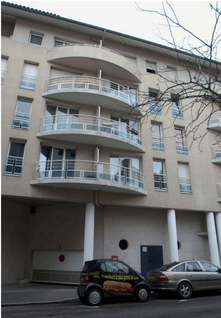
Entrée et détail des balcons
