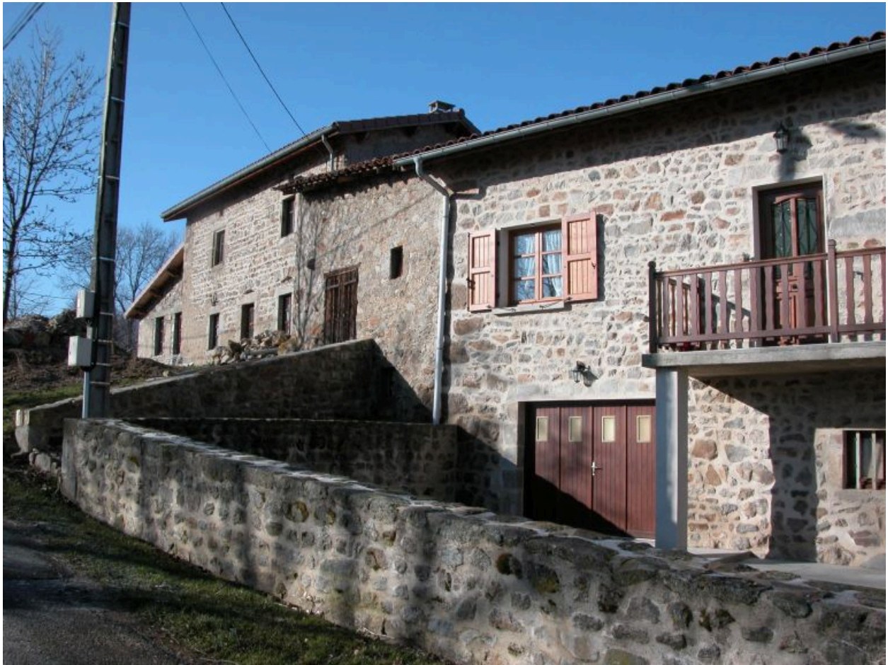
Parcelles 172, 166, vue d'ensemble des façades sur cour.
