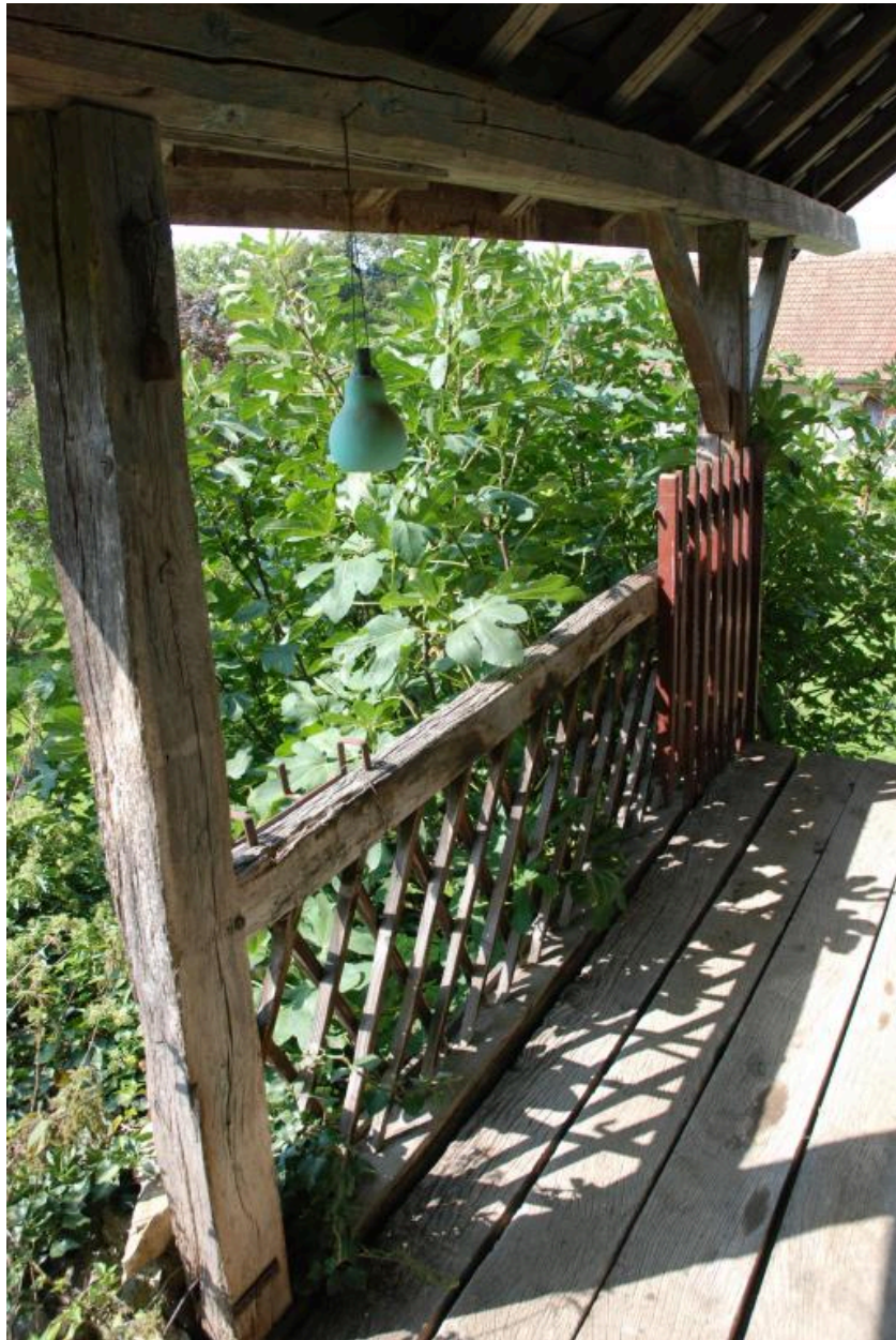
Façade sud de la Pigeonnière, Vue d'ensemble de la galerie située au premier étage avec garde-corps avec motif de treillis.
