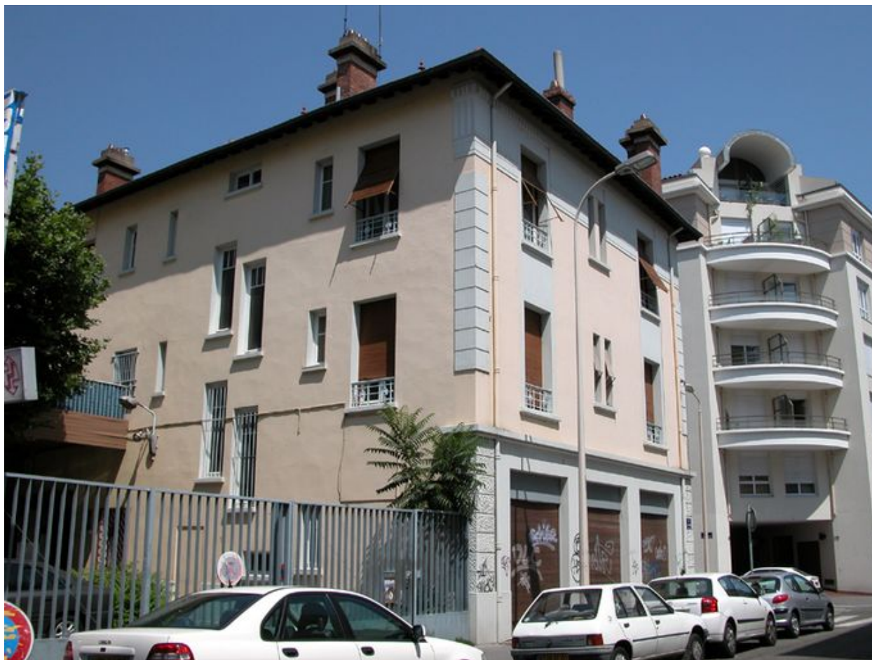
Immeuble : élévations sud et ouest
