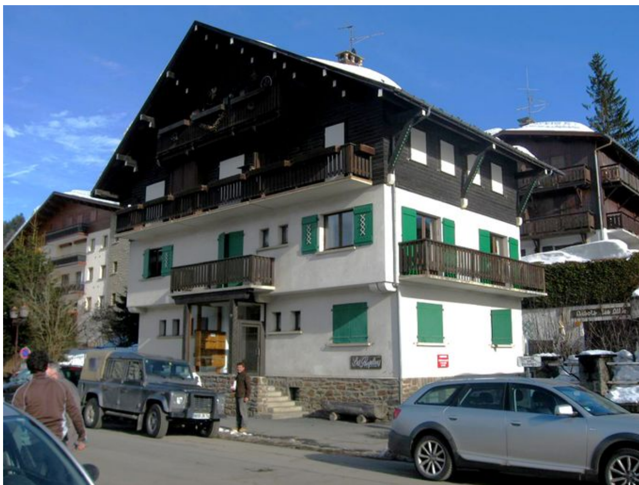
Hôtel les Peupliers, 320 rue Charles-Feige, construit en 1951 par H.J. Le Même
