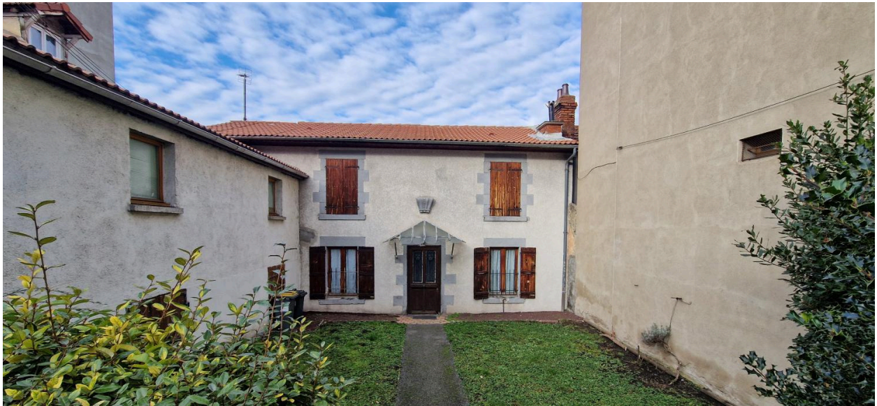
Façade en retrait d'alignement, boulevard Jean-Jaurès
