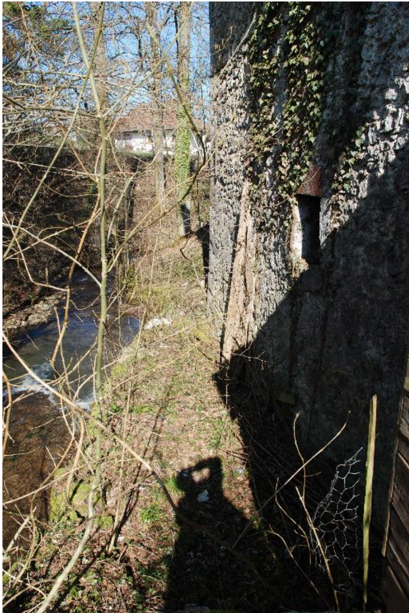
Elévation du mur pignon ouest de la partie moulin
