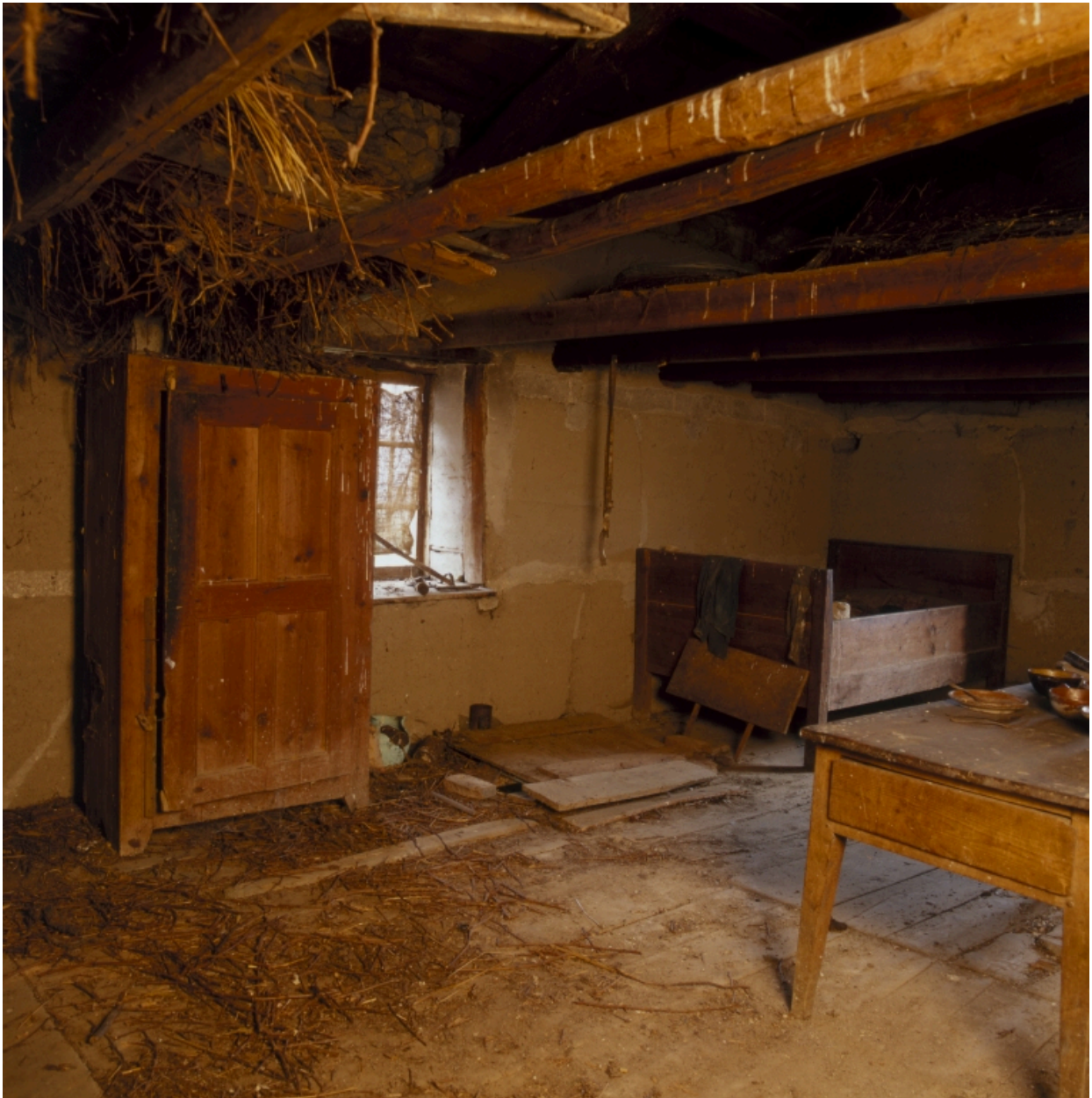
Vue intérieure de l'étage, angle sud-est..
