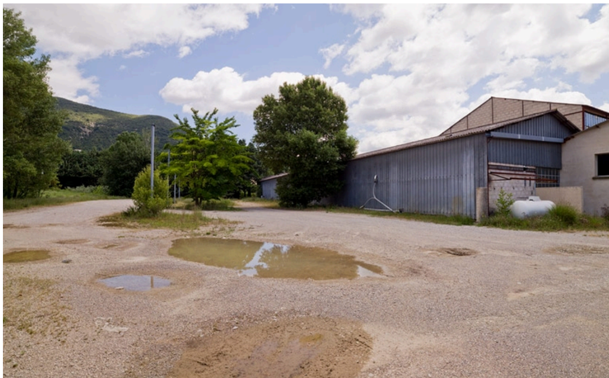
Vue d'ensemble ouest
