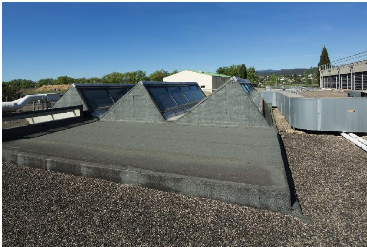
Toitures : sheds sur patio du bâtiment socio-culturel
