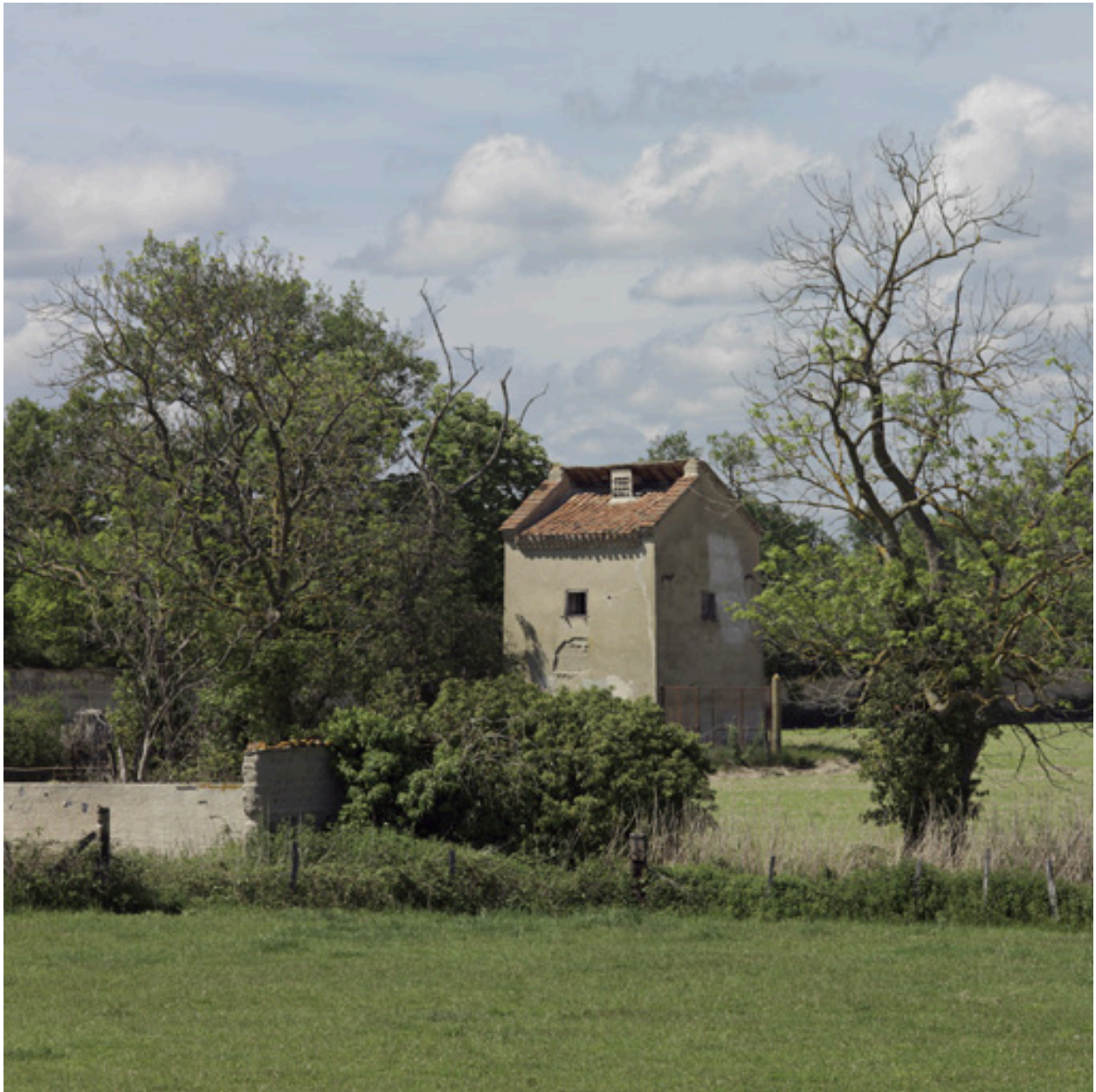
Vue générale depuis le sud-est.
