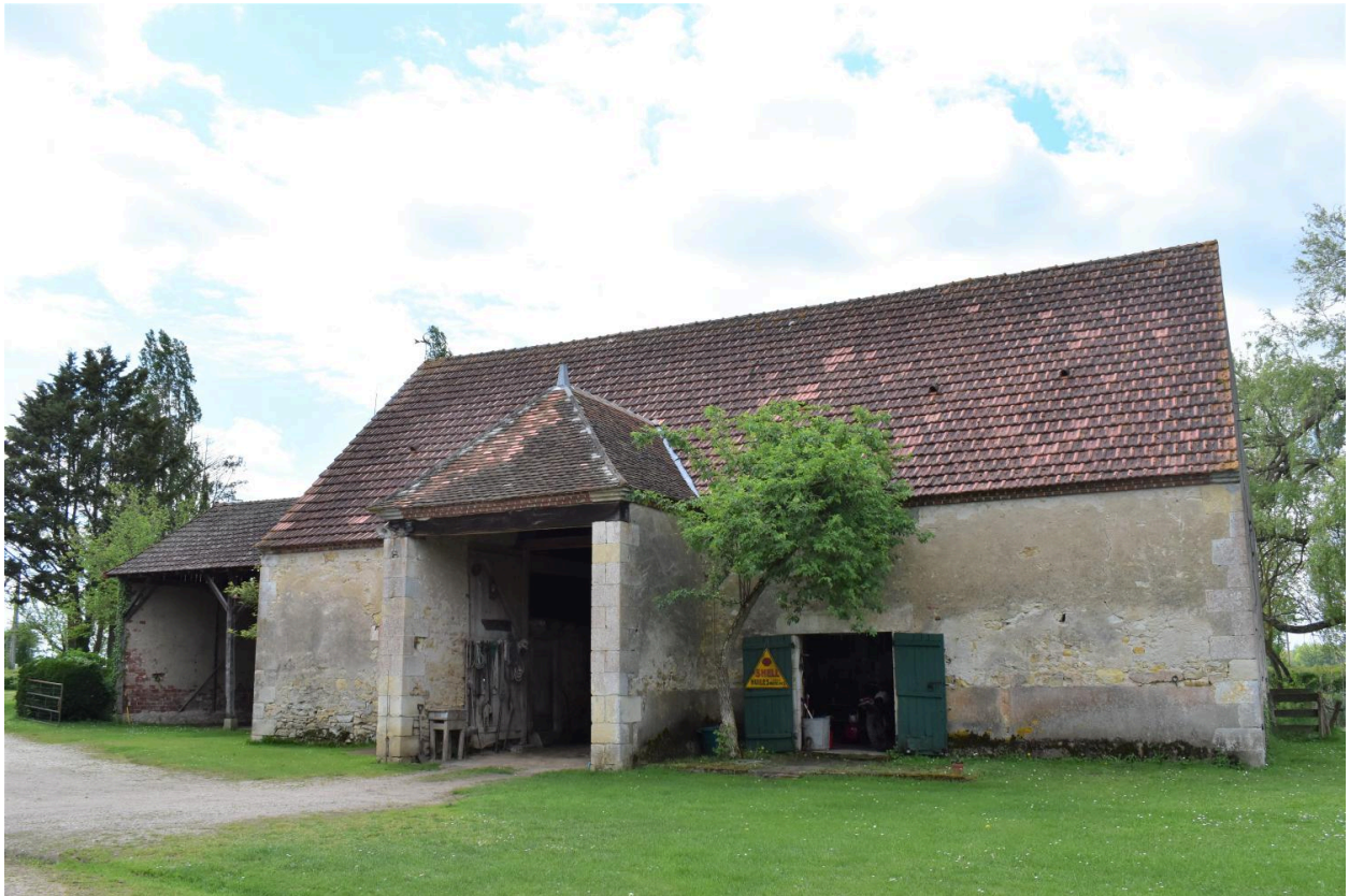
Vue générale de la grange à auvent.
