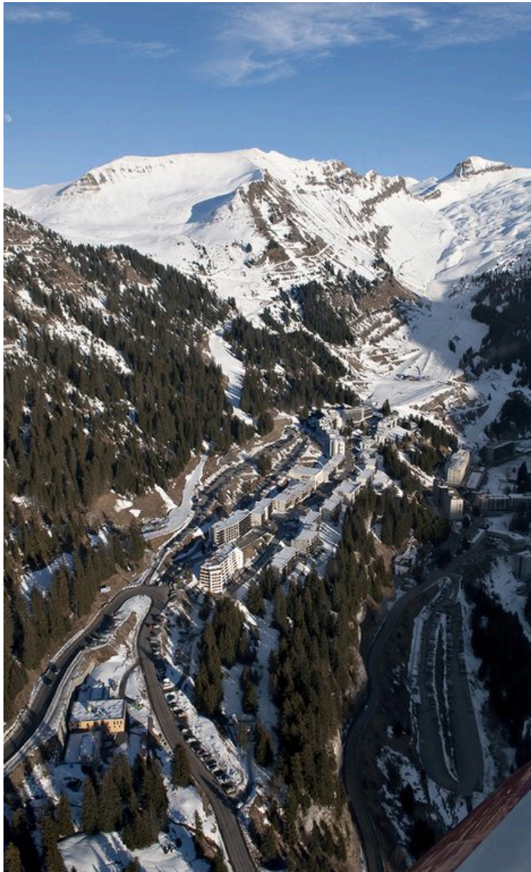
Vue aérienne de la station depuis l'ouest
