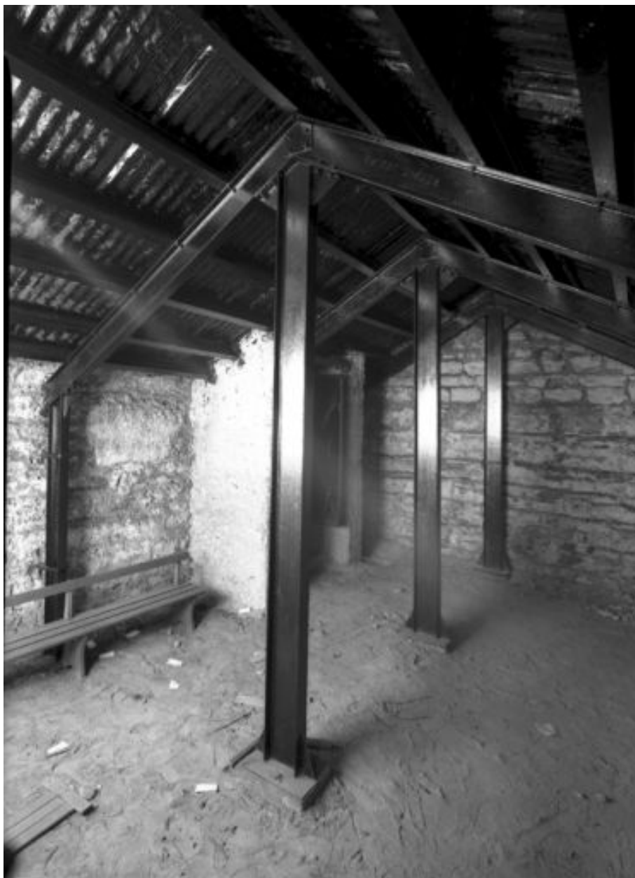
Ecole maternelle : vue partielle d'une cave construite en pierre et renforcée par une charpente métallique
