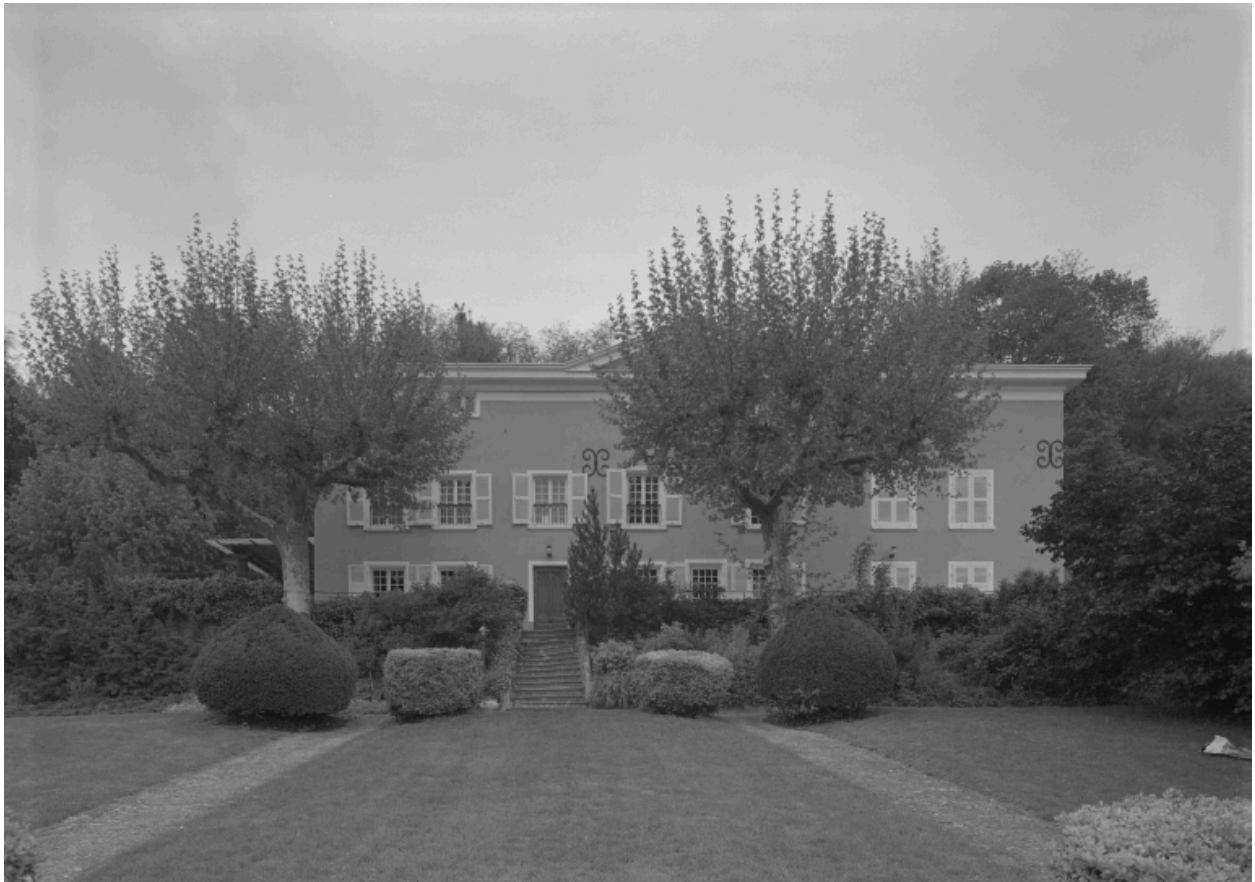
Maison de notable, 16 boulevard de l'Industrie, type VII* : façade couronnée d'un fronton axial.
