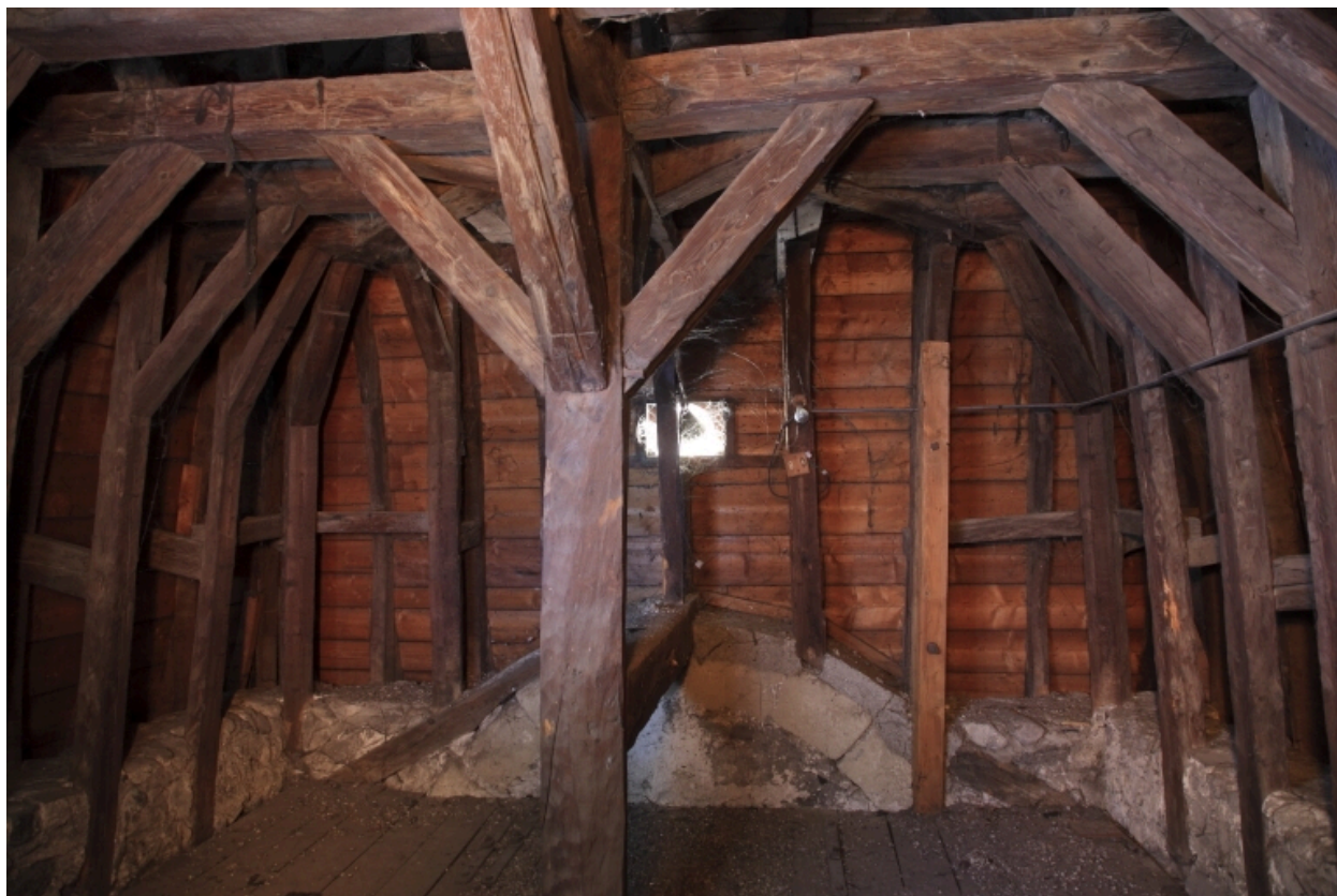
Bâtiment A. Campanile : charpente
