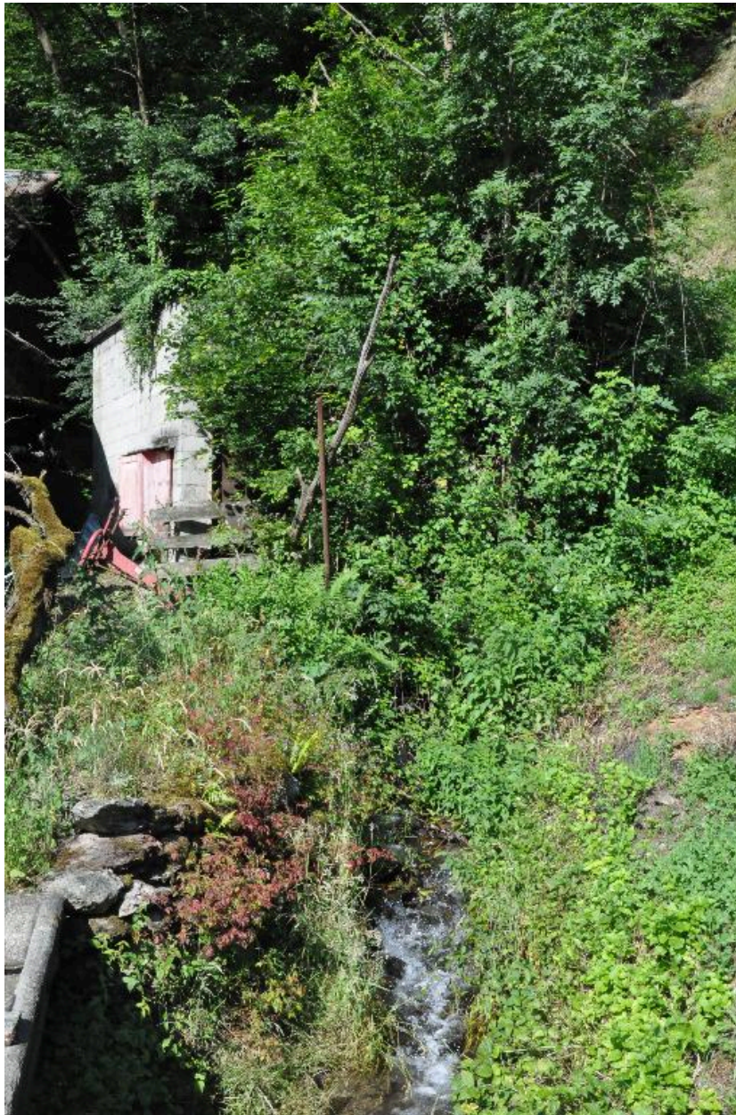
La centrale Traversier vue depuis la route.
