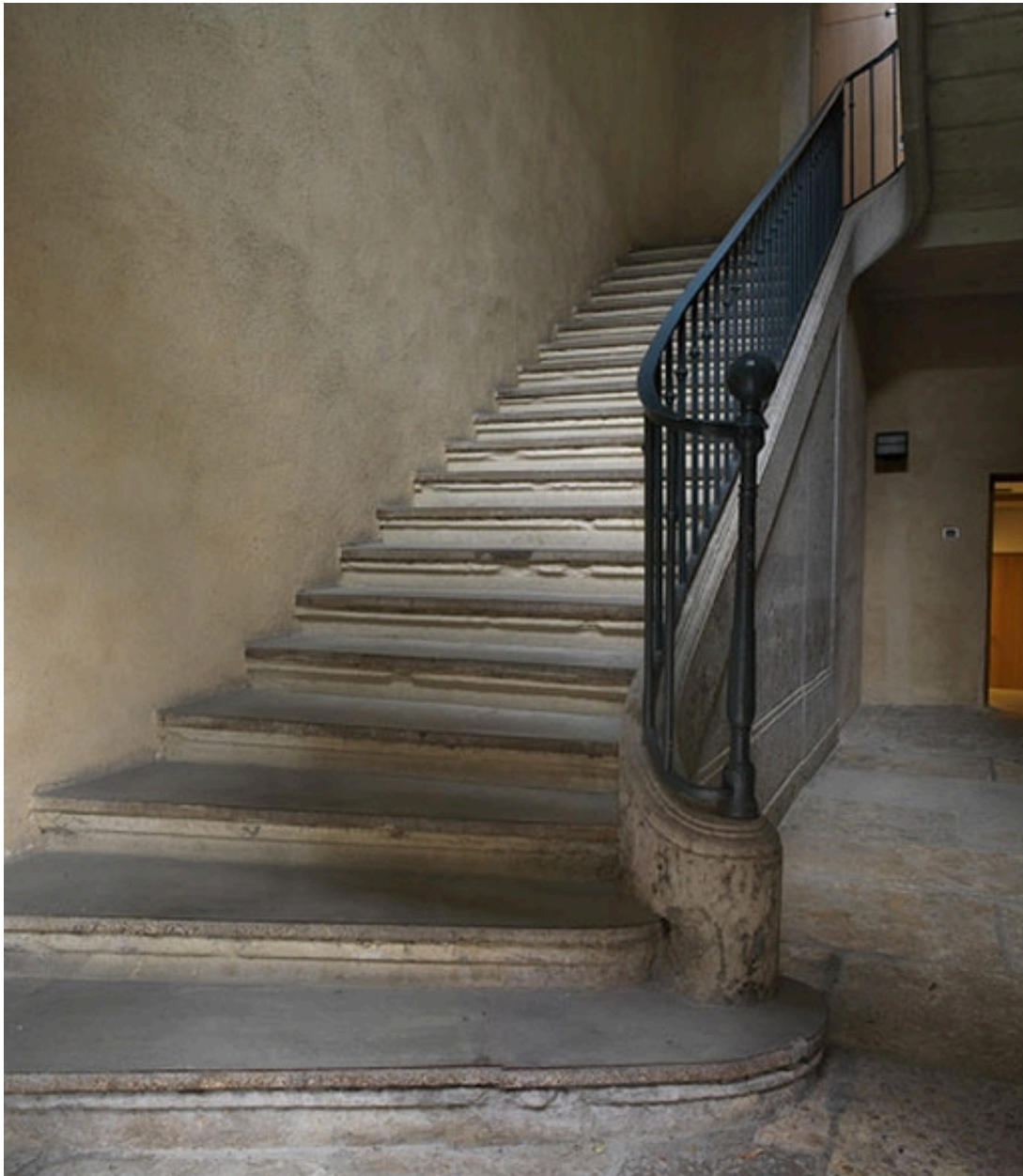
Escalier axial nord.
