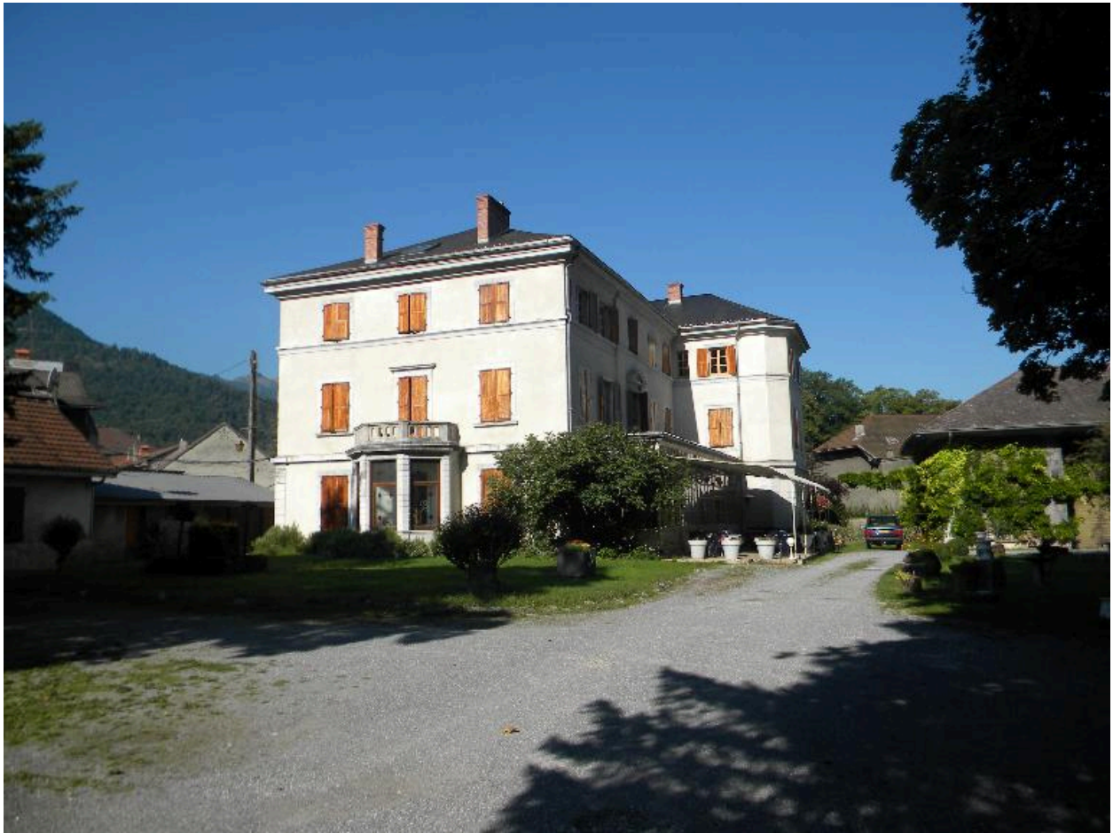
Vue du pignon est.
