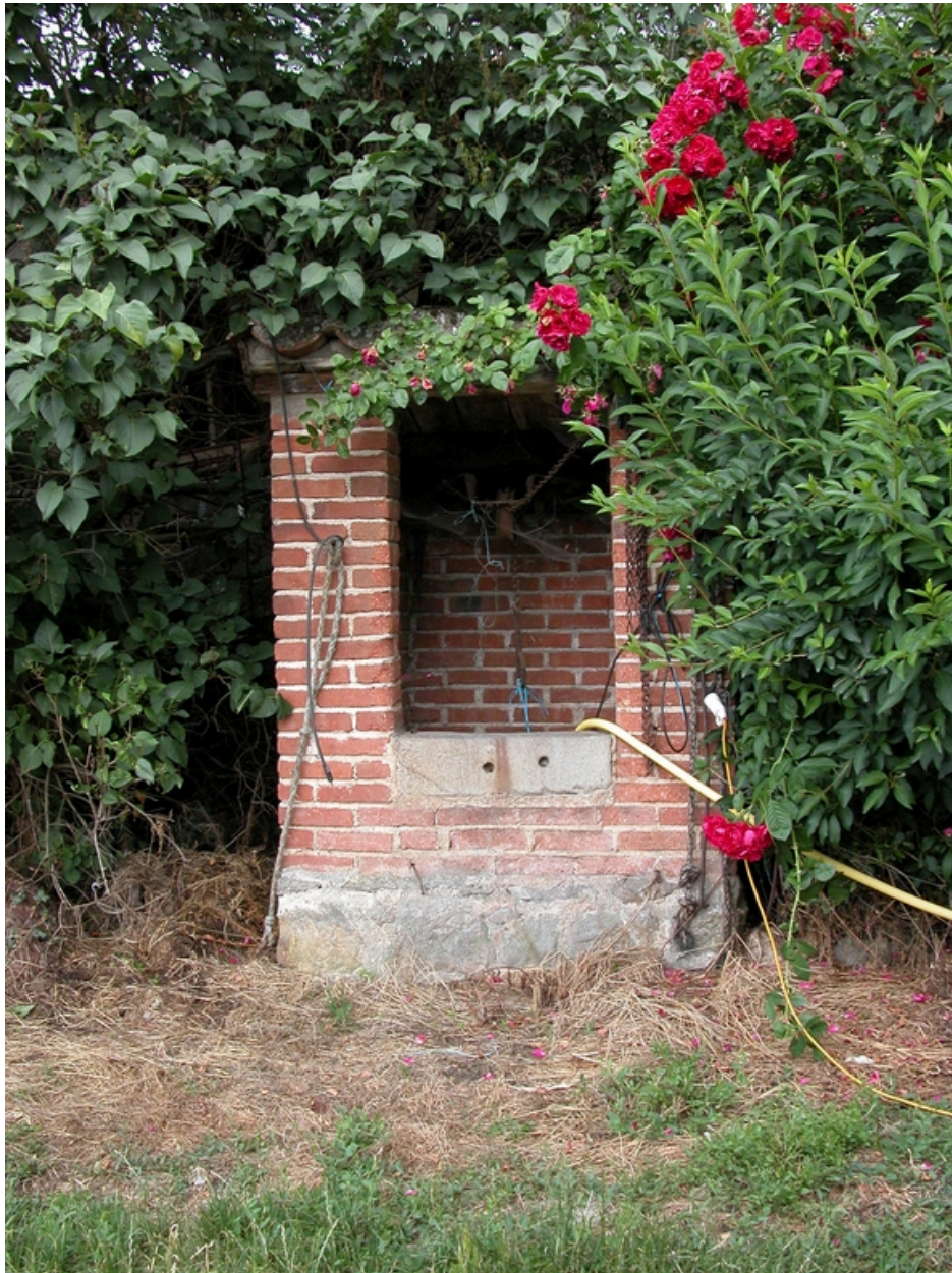
Vue du puits (1999 ZI 55).
