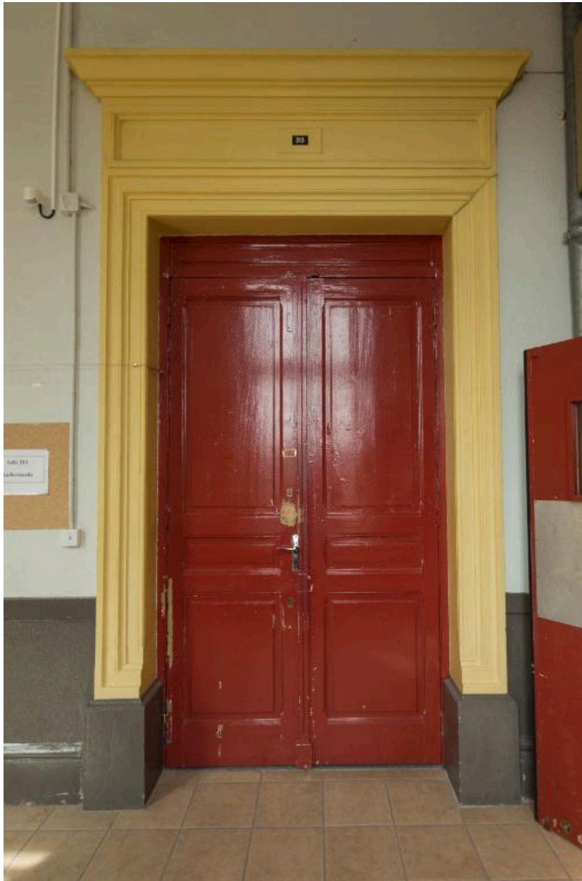
Bâtiment H. Aile Le Coeur Bellet. Porte du 17e siècle donnant accès à l'espace vers la chapelle
