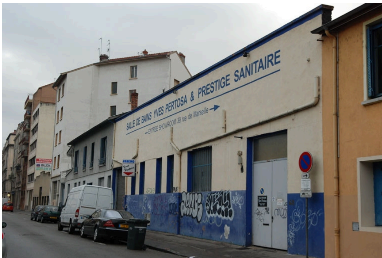
Vue générale nord
