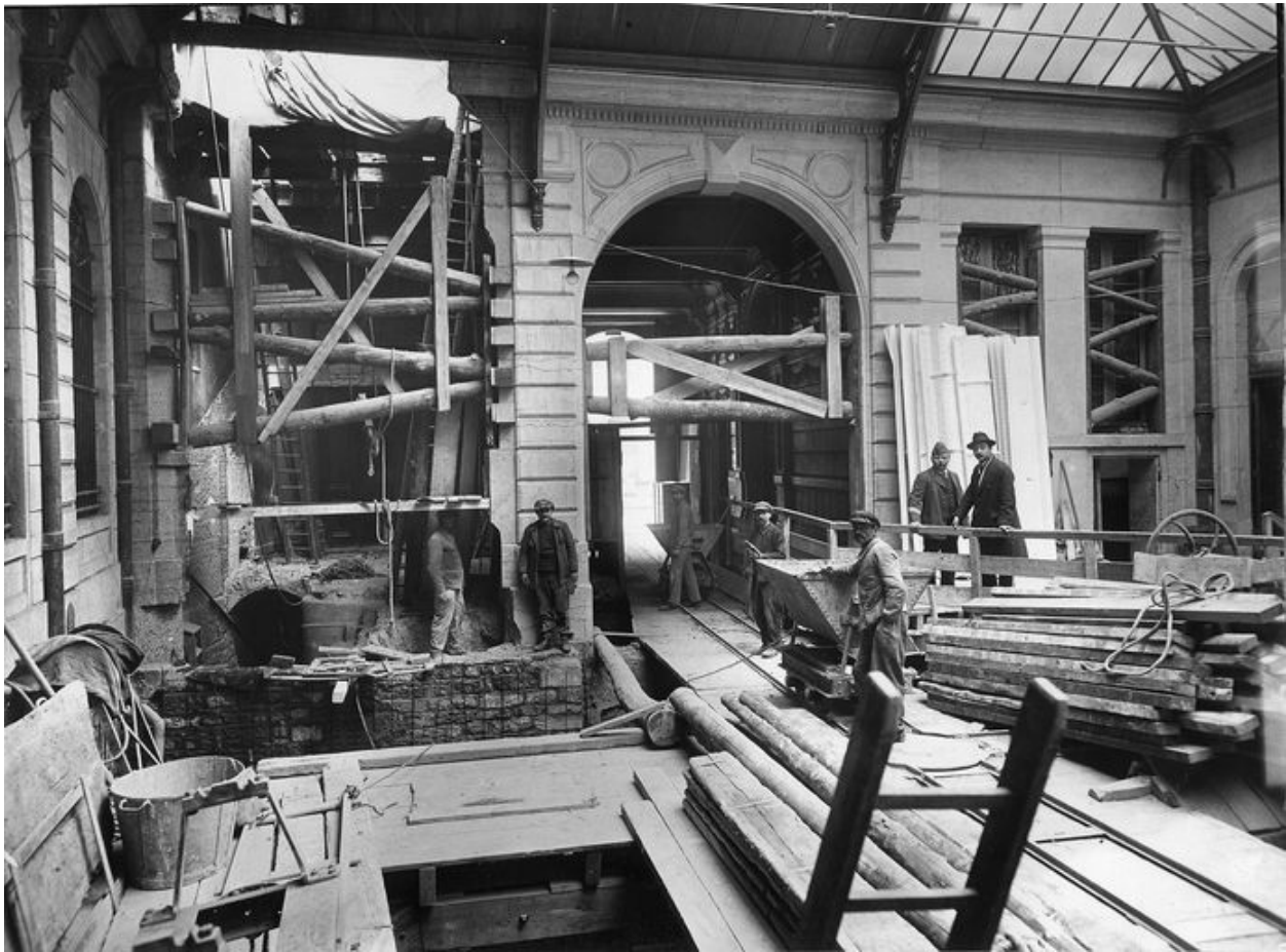
Vue du chantier d'aménagement de l'escalier des bureaux, en 1921-1922 (Banque de France, PHAR, non coté, photographie).
