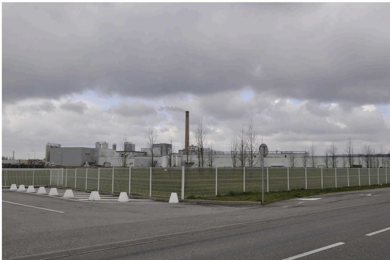
Vue de l'usine est
