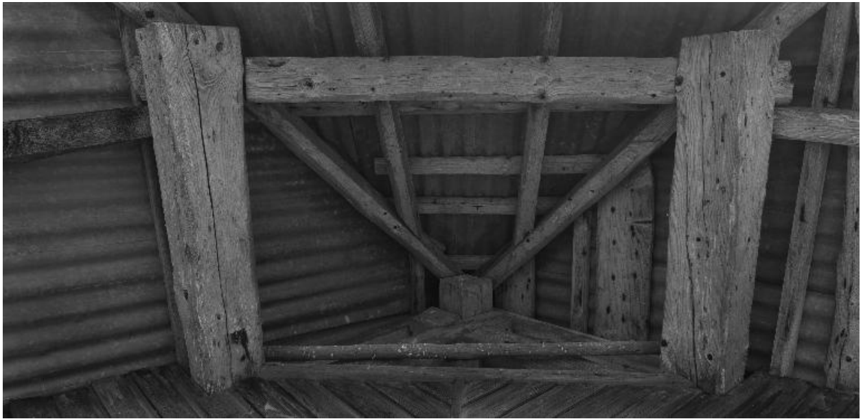
Détail de la charpente supportant une des demi-croupes.
