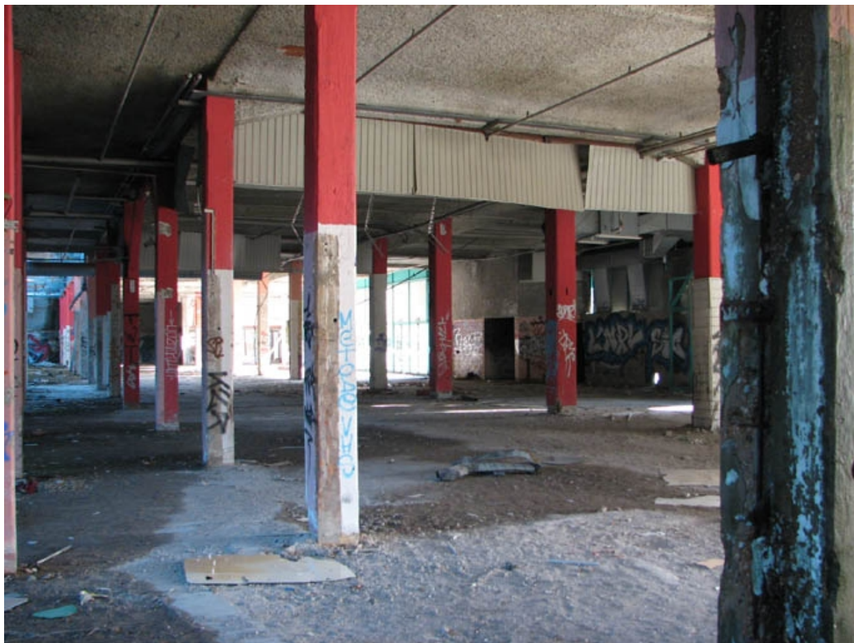
Atelier en rez-de-chaussée du bâtiment principal : détail poteaux béton
