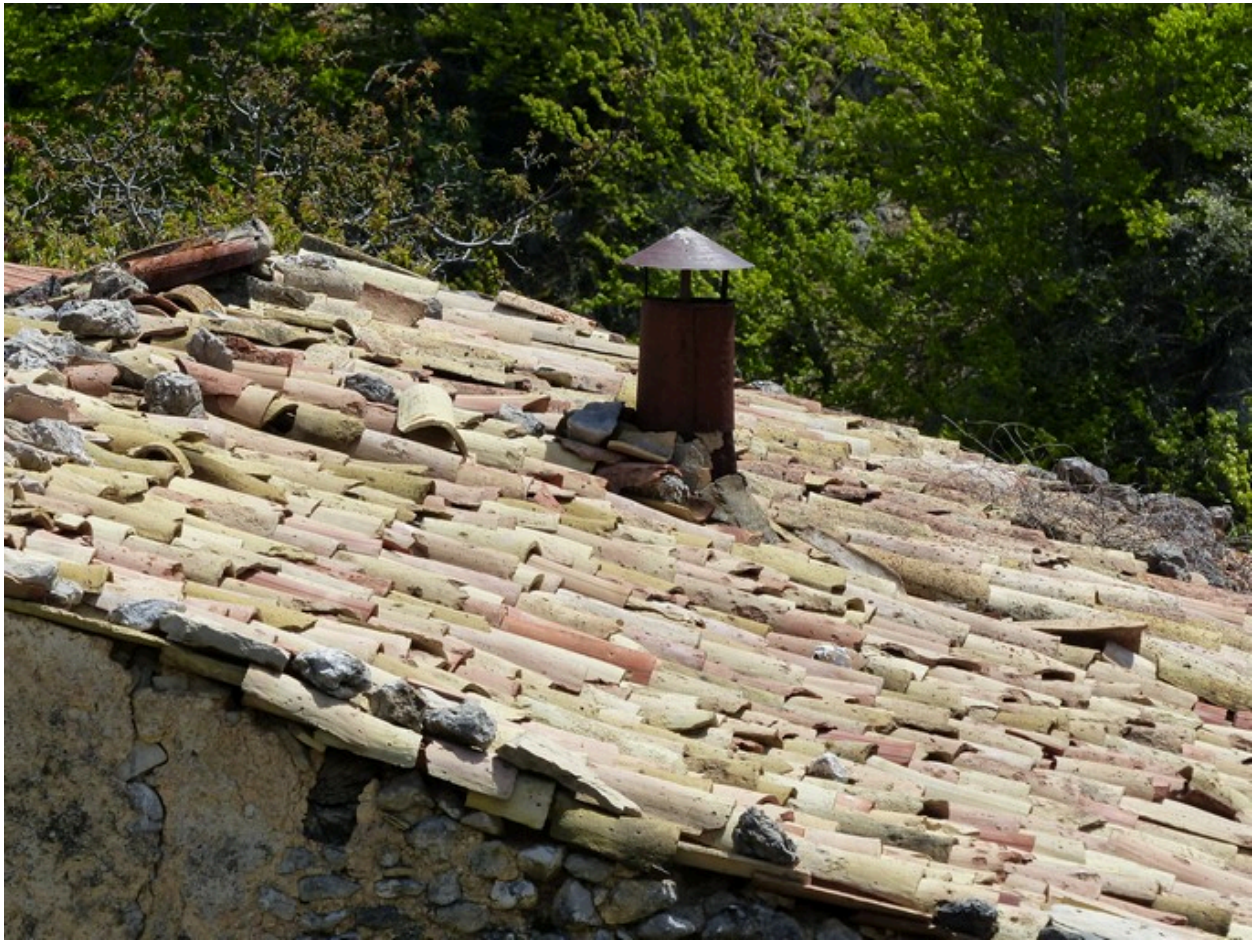
Ensemble oriental. Couverture en tuile creuse.
