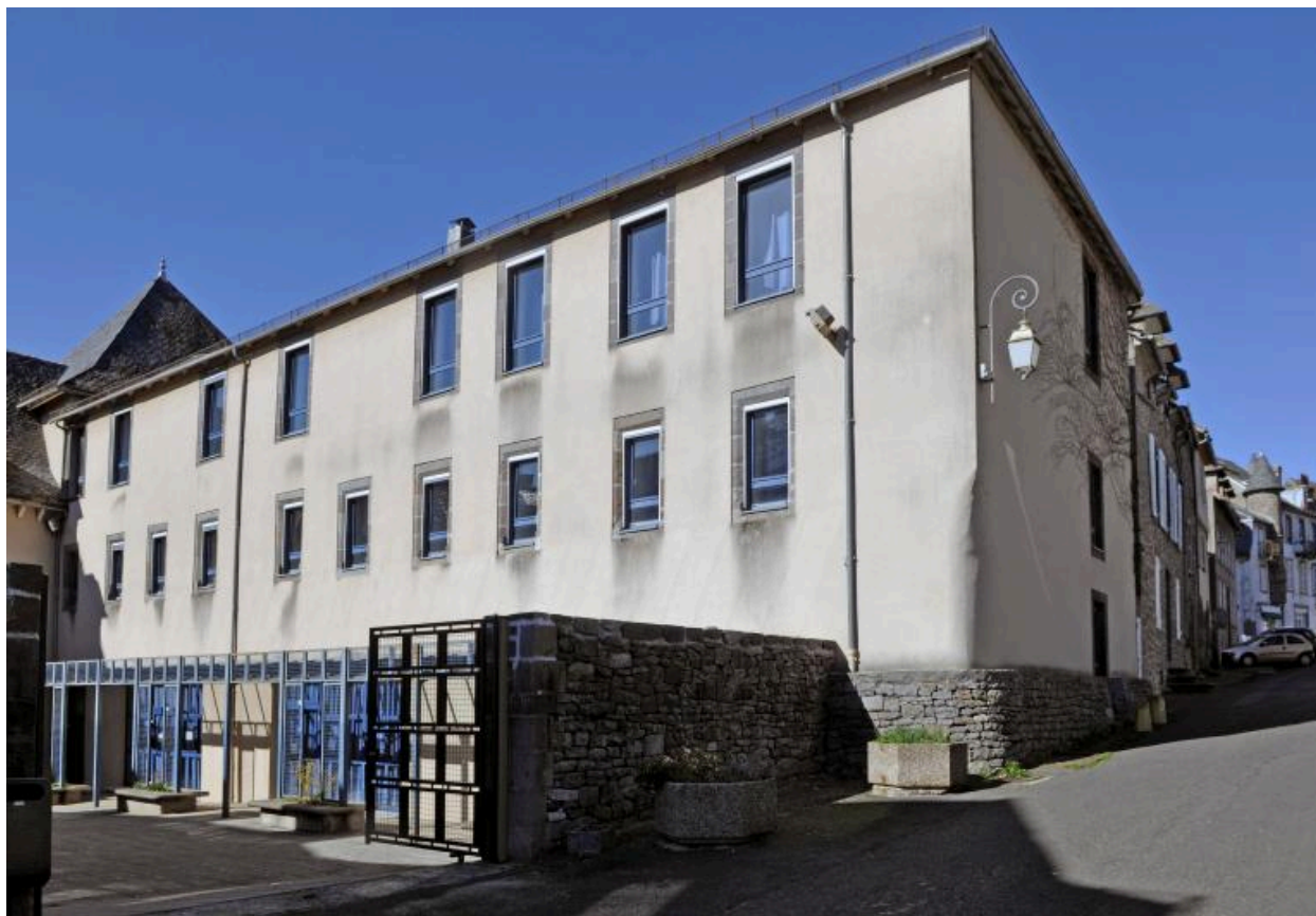
Cour nord, corps de bâtiment nord
