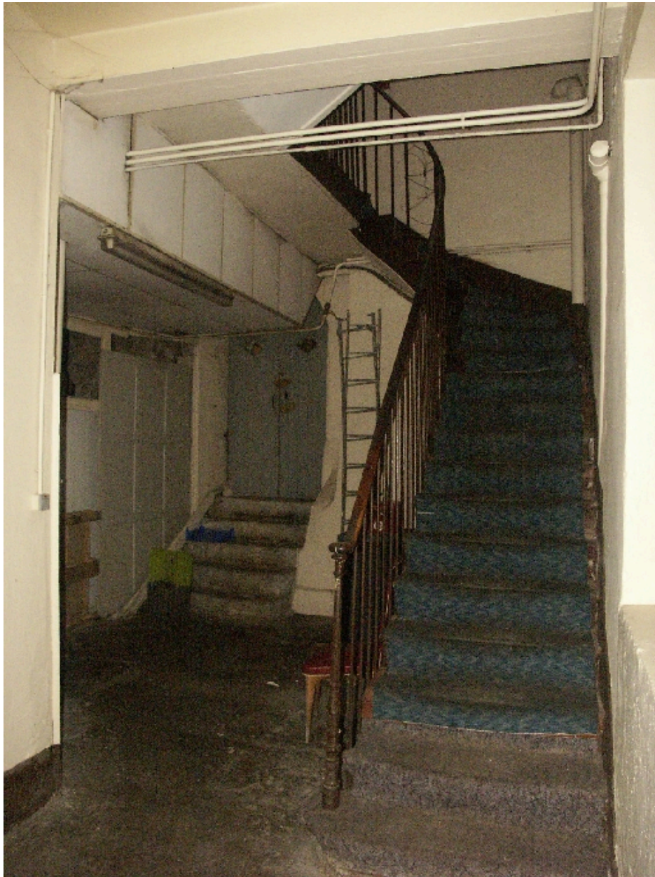
Escalier d'accès au sous-sol
