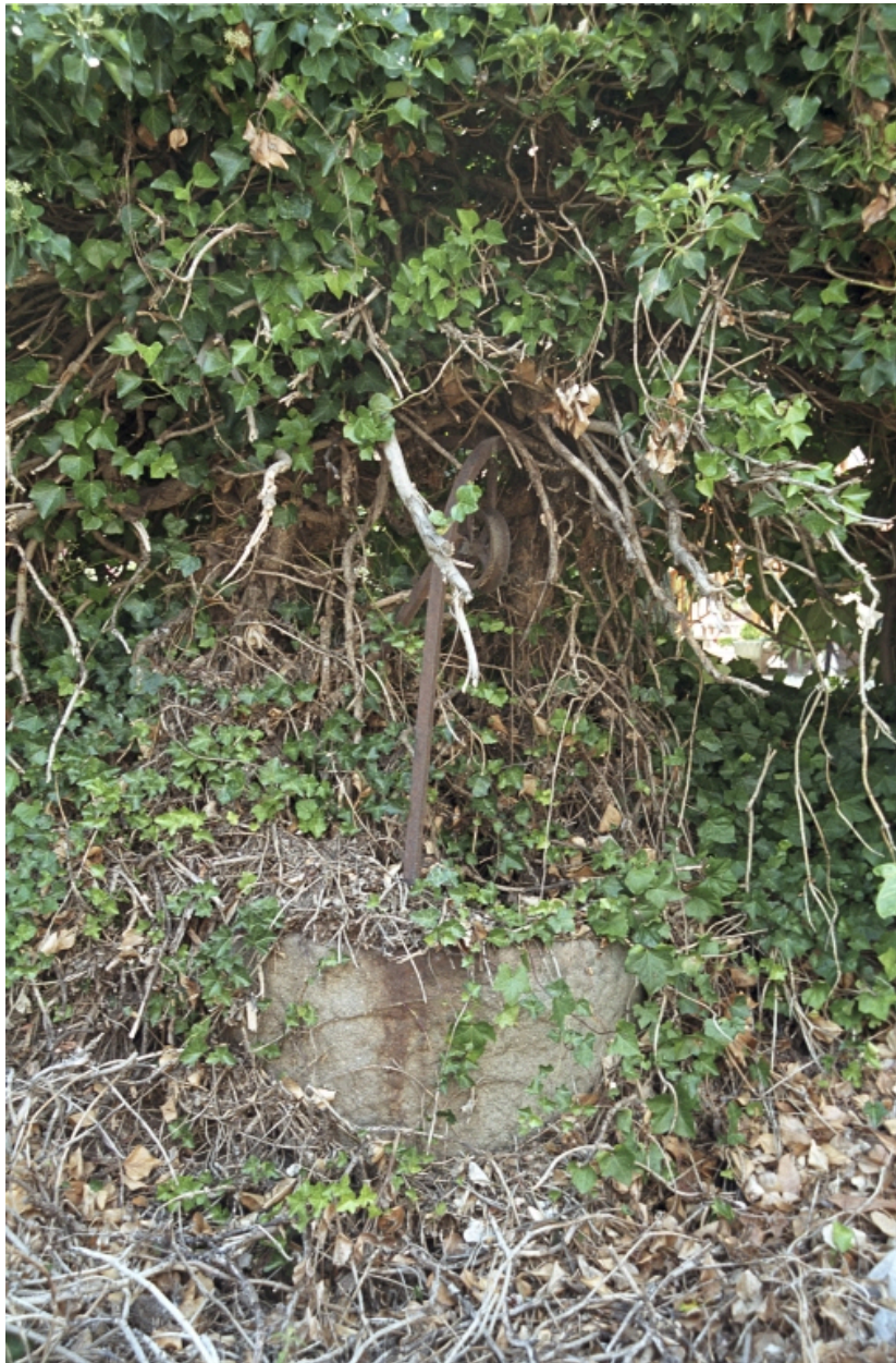
La Chaux-Est, puits, section AE 291. Vue d'ensemble.
